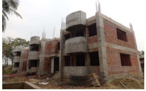
বিএনএ বঙ্গবন্ধু কমপ্লেক্স, পতেঙ্গা-এর নির্মাণাধীন সেইলর্স ব্যারাক
