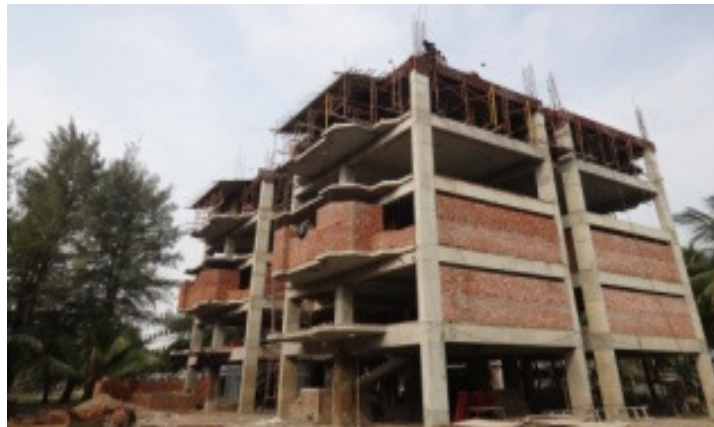
বিএনএ বঙ্গবন্ধু কমপ্লেক্স, পতেঙ্গা-এর নির্মাণাধীন জেসিও'স মেস
